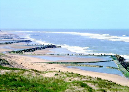
Travaux de protection du littoral
